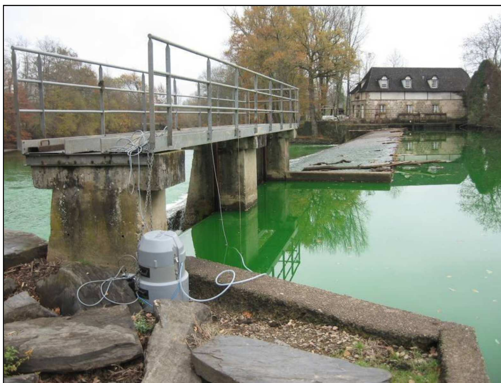
Exemple de matériel de suivi – Pont de Garavet
