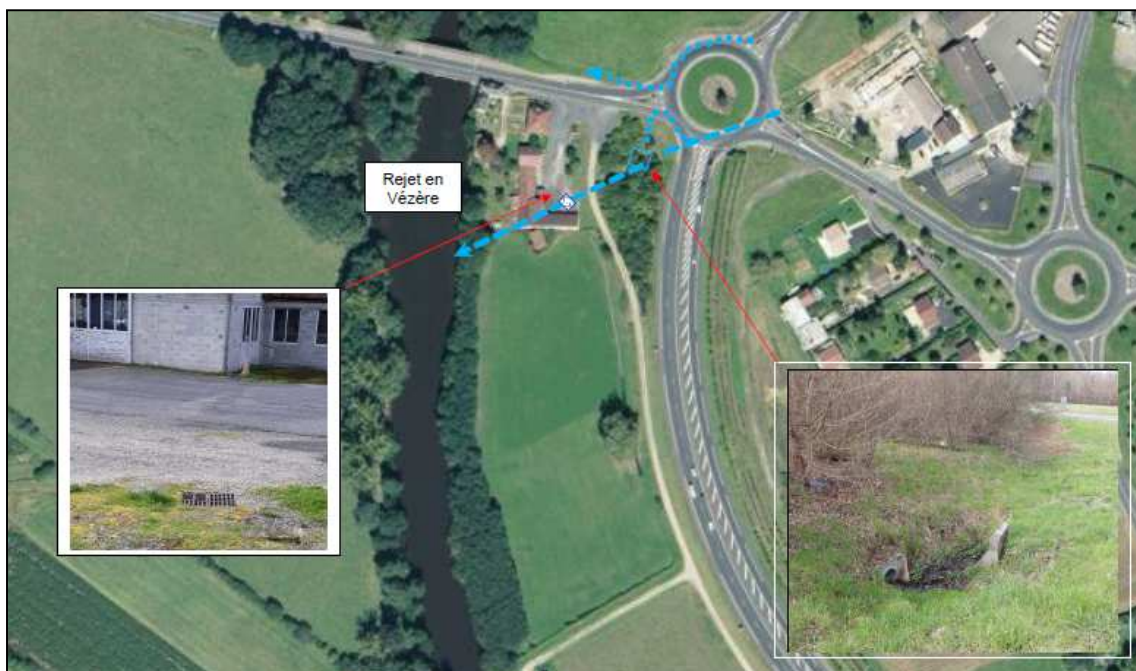
Localisation des rejets directs en Vézère au niveau du giratoire de la RD 901
