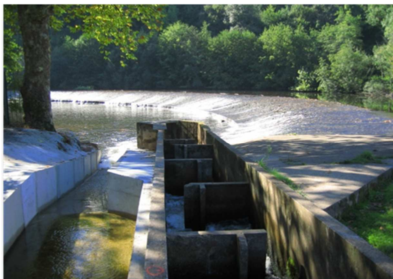
Photos de la digue, de la passe à poissons et de la passe à canoës
